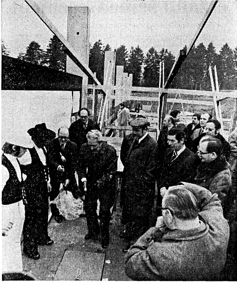
Im Gewinn Büchsenköpflein in Ziegelhausen wird ein weiterer Bauabschnitt des Sport- und Erholungszentrums entstehen. Unser Foto zeigt OB Zundel bei der Zeremonie der Grundsteinlegung. (Foto: Ballarin)
